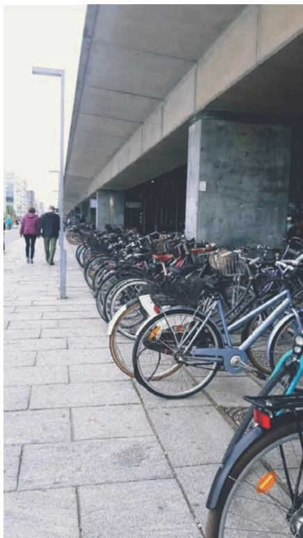
Estación de metro Orestad St. Copenhague, Dinamarca.
