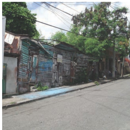
FIGURA 9. VISTA CALLE GARABITO.
